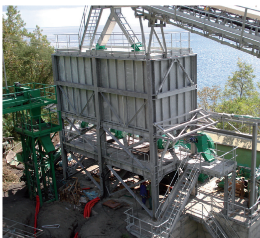
Installation au montage SDG Guadeloupe
