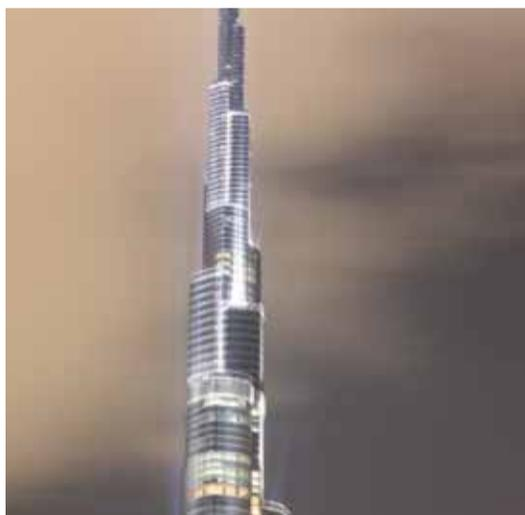
**Cette antenne en acier** a été construite à l'intérieur même de la tour puis hissée sur 200 mètres par un système de pompe hydraulique.
